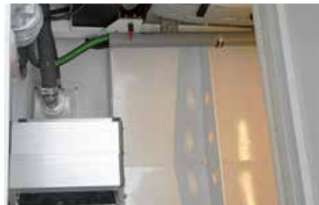
Im „Keller“ unter dem Cockpit der Generator und reichlich Stauraum für Fahrräder etc.
