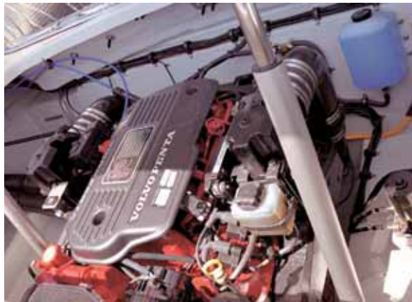
Saubere Installation im Motorraum.
