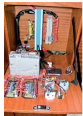
Elektrik der Delphia 1050.
