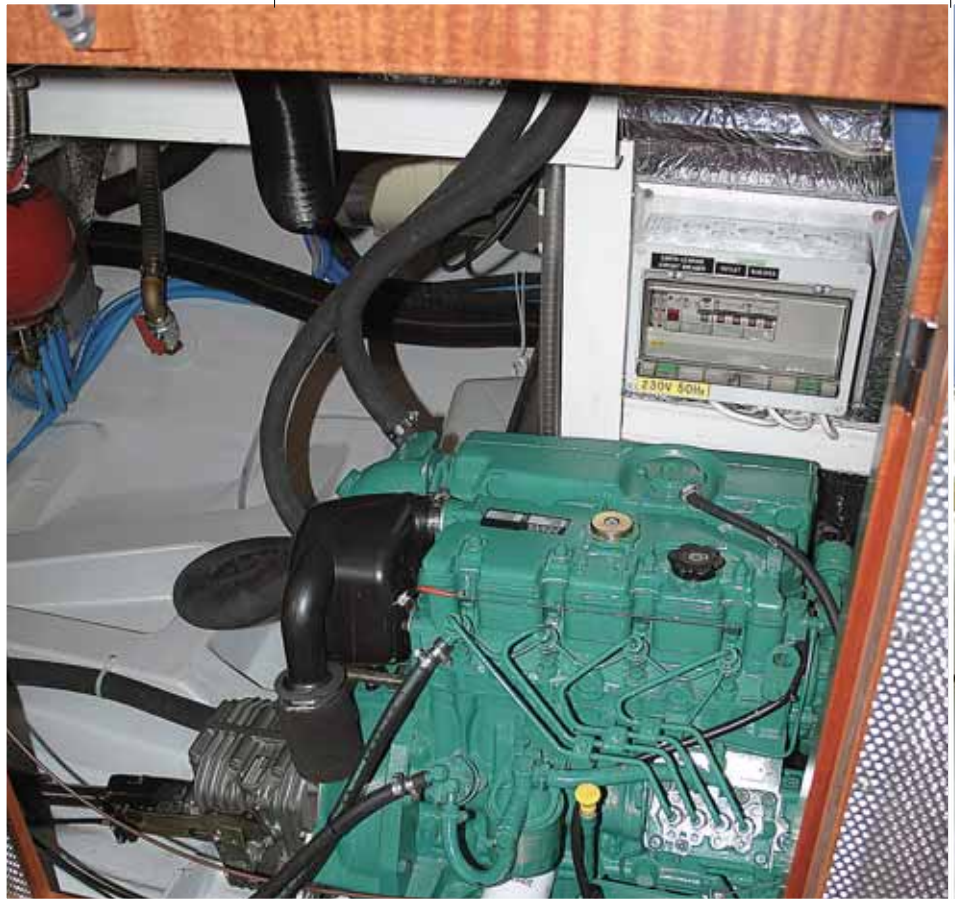
Oben: Die Maschine und andere technische Geräte und Aggregate sind in einem separaten und großzügigen Raum untergebracht. Die Wartung kann hier ohne „zusätzliche Ellbogen und Handgelenke“ durchgeführt werden. Alles ist frei zugänglich.
