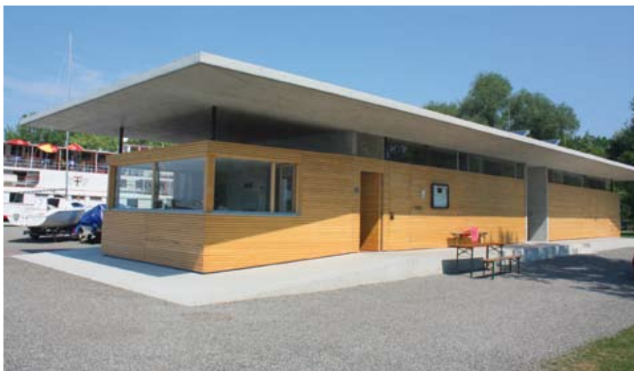
Der Hafen Lochau wurde grundlegend saniert. Neue Stege, neue Mole und sogar ein neues Hafengebäude wurde erstellt.
